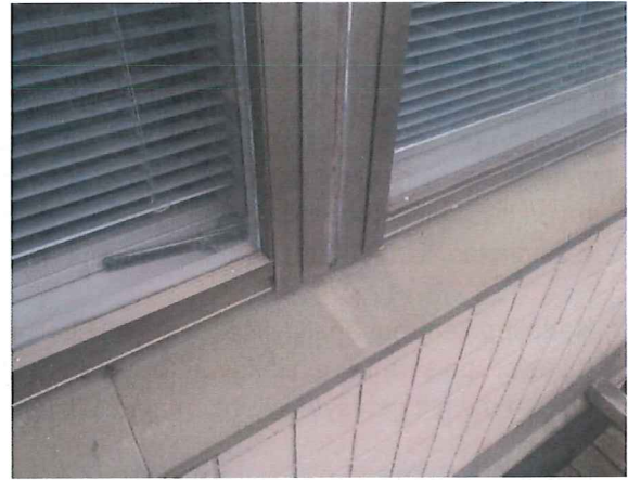
Kuva 14. 3-lasinen MSE-puuikkuna ulkopuolelta.
