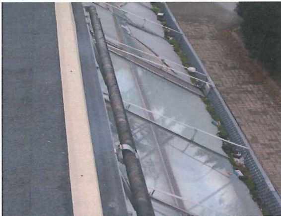
Kuva 19. Erkkerin lasikatto, lumieste ja markiisi. Siivous ja lasikatteen pinnoitteiden poisto.
