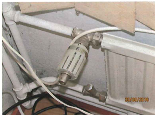
Kuva 4. Oraksen valmistama patteritermostaatti vuodelta 1986..
