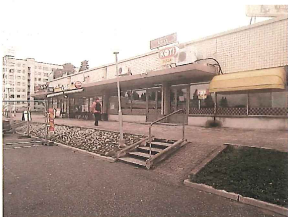
Kuva 1. Kulkutie, nurmikko-, nupukivikaista sekä portaikko ja luiska rakennuksen eteläpuolella.
