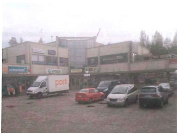
Kuva 7. Elementtijulkisivuja etelään ja länteen päin. Keskellä keskusaulan sisäänkäynti.
