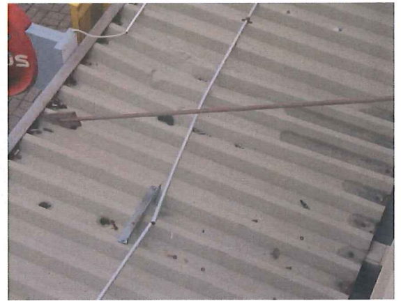
Kuva 22. Kattolipoille on jäänyt asennustarvikkeet ja poistettavat johdotukset.
