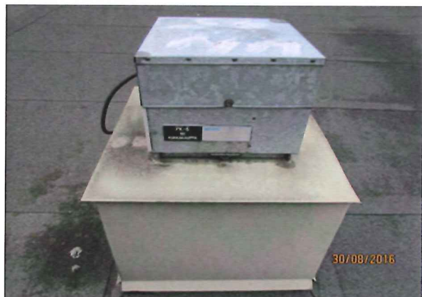
Kuva 10. R-kioskia palveleva poistoilmakone vuodelta 1986.
