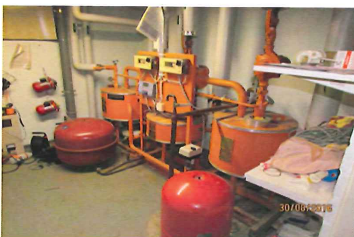
Kuva 1. Kiinteistön alajakokeskus asennusvuosi on 1985.
