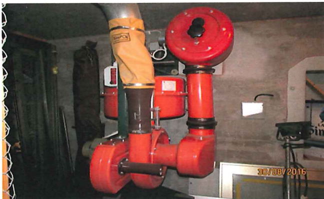
Kuva 12. Temetin valmistama väestönsuojan IV-laite.
