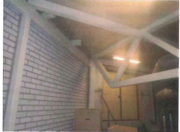
Kuva 30. Teknisen tilan teräsrunkorakenteita ja tiiliseinää.
