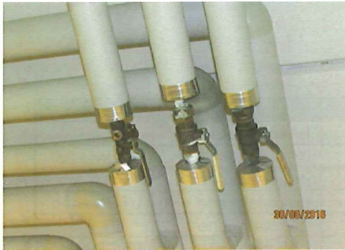
Kuva 5. Käyttövesiverkoston palloventtiilejä.
