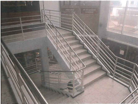
Kuva 27. Keskusaulan portaikko kaiteineen.
