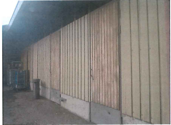
Kuva 32. Kylmien ulkovarastojen profiilipeltiseiniä ja puupaneelipintaisia ovia.
