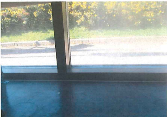
Kuva 11. Kukkakaupan eristelaselementti ei ole toimivassa kunnossa.
