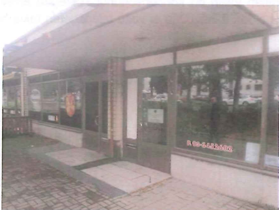
Kuva 15. Ulko-ovia ja sisäänkäyntiä ulkopuolelta.
