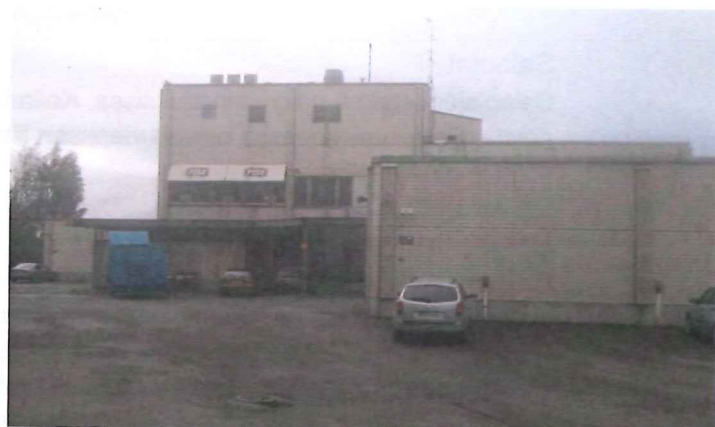
Kuva 8. Elementtijulkisivuja pohjoiseen päin. Kylmien varastojen profiilipeltijulkisivua. Takapihan ovi-ikkunaseinä.
