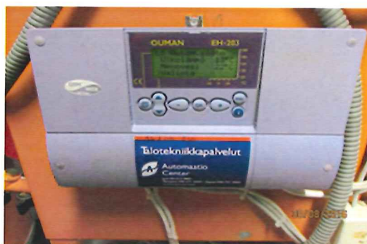
Kuva 2. Digitaalinen säätöyksikkö Ouman EH-203
