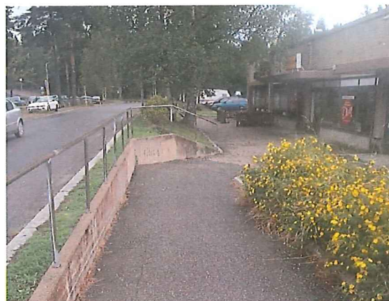
Kuva 2. Tukimuuri kaiteineen ja viherrakenteita rakennuksen länsisivulla. Rakennuksen vierustan kulkutien kallistus on vähäinen.
